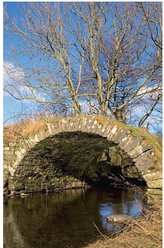
Ettrick Bay Bridge
